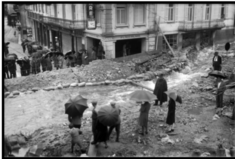
Immagine 15: Dopo un violento acquazzone la Ramogna è straripata e i detriti hanno sotterrato il ponte, (foto degli anni '30).
